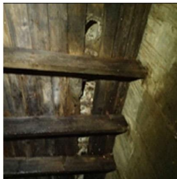
Figur 1-15 Skada vid längdmeter 75 och kvarsittande form.
