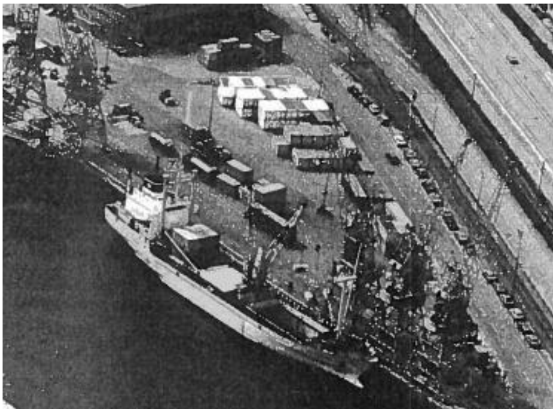
Figur 1-11 Detalj som förefaller visa containeruppställning över påldäcket. Bild "Utbyggnad av Göteborgs hamn under åren 1962-1987"
